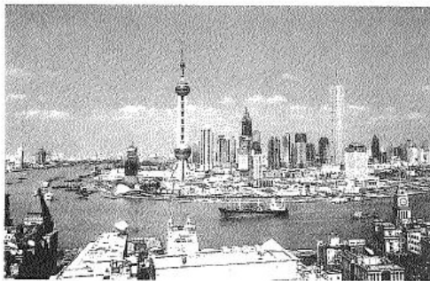
Ein Blick auf den Hafen und den Funkturm von Shanghai.
