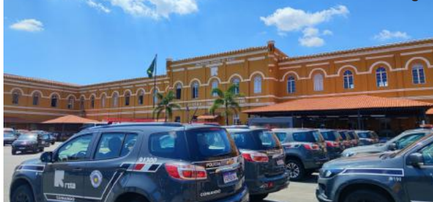
Ein Blick auf den Innenhof und einen Teil der Dienstfahrzeuge
